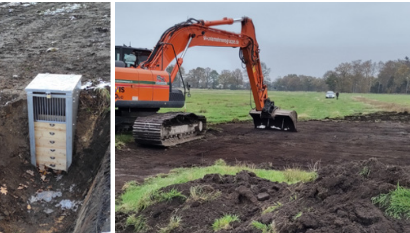
Links: Der Teichmönch sorgt für einen konstanten Wasserpiegel. Rechts: Wenn die Bagger schon mal da sind ... Fotos: DVL
